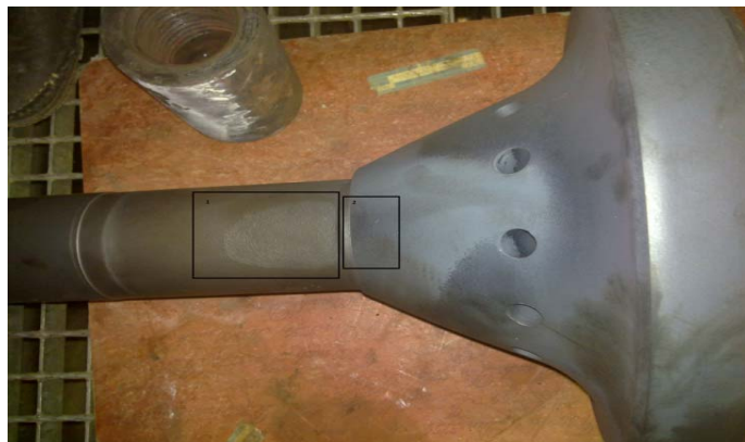
شکل ۱۰- خوردگی در ساقه و دیسک شیر که منطبق با محل های ماکزیمم تنش (حاصل از نتایج مدلسازی در شکل ۹) است
