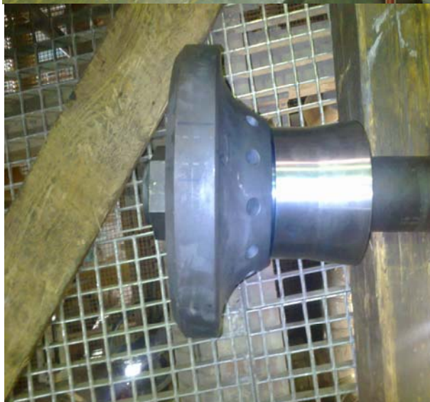
شکل ۱۷- ساخت غلاف پوششی ساقه و نصب آن روی ساقه کنترل والو شیر کنار گذر واحد ۴ در آذر ماه ۹۱
