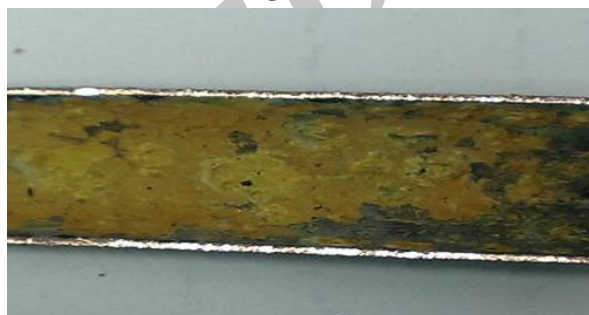
شکل 12: نمای نهایی درون لوله پس از اسید شویی توسط اسید سیتریک 3%
