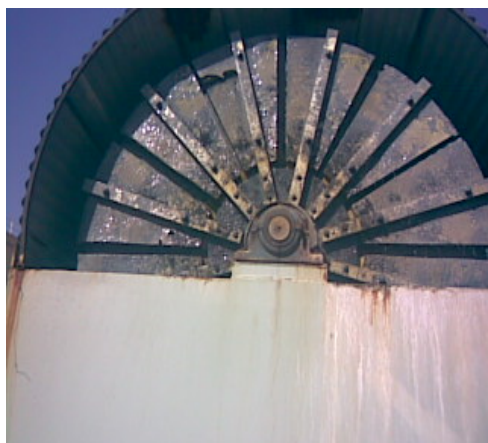
شکل 1 - شماتیک سیستم راکتور بیولوژیکی چرخان نیروگاه خیام
