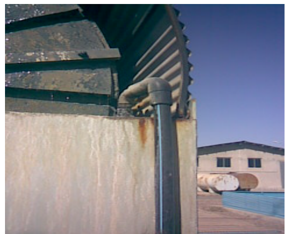
شکل 2- اختلاط پساب بهداشتی با پساب تمیز ناشی از شستشوی معکوس فیلترهای شنی در ورودی سیستم بیودیسک
