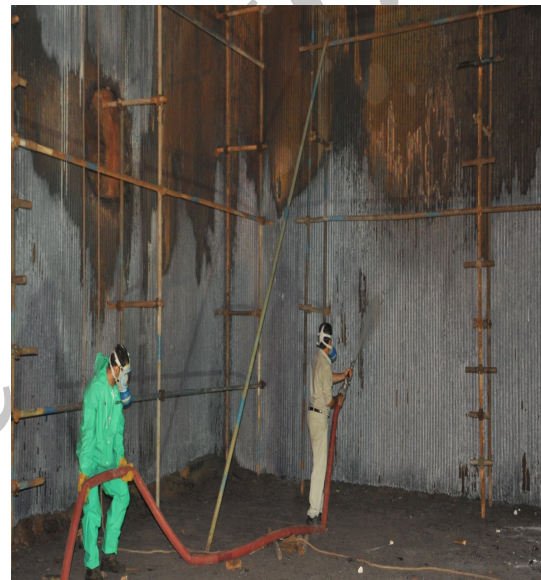
شکل (۴): عملیات قلیا شویی بویلر واحد ۳
