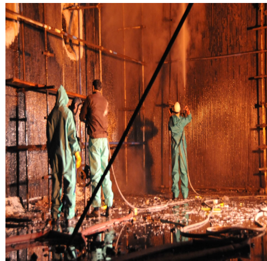
شکل (۵): عملیات قلیا شویی بویلر واحد ۳
