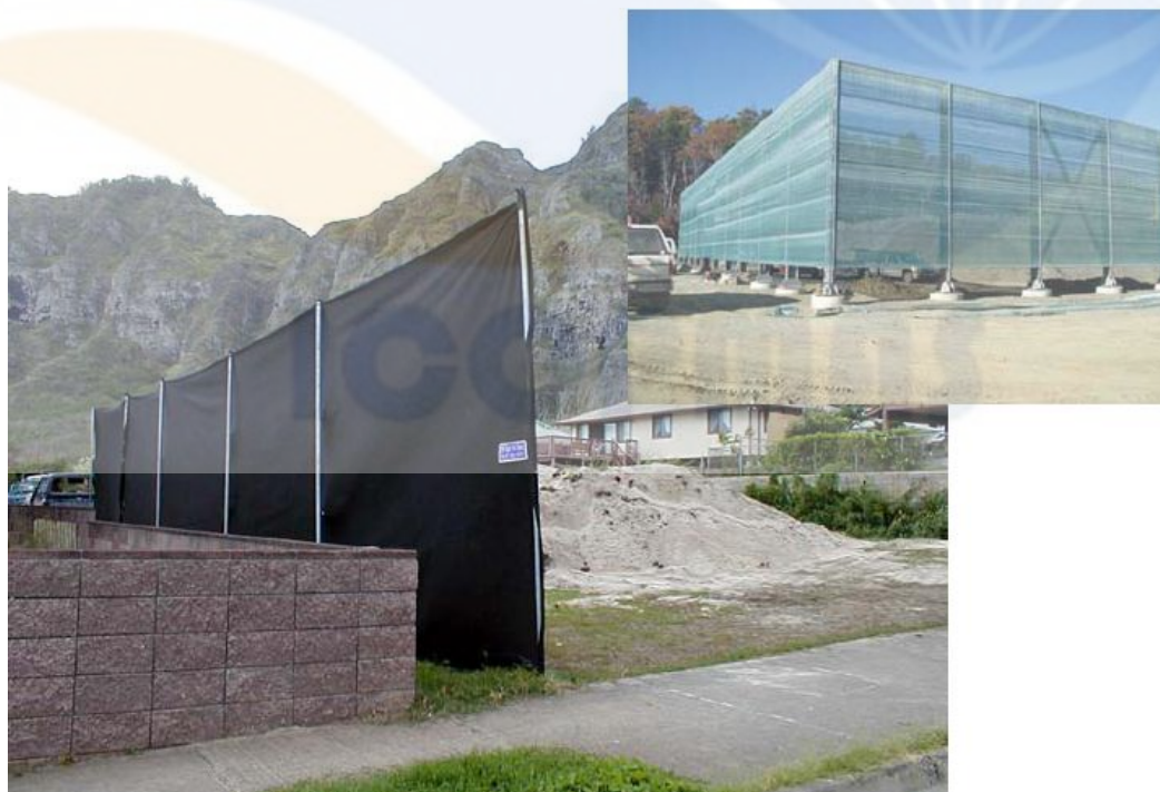
شکل 5- استفاده از دیوارهای موقت جهت جلوگیری از انتشار گرد و غبار
