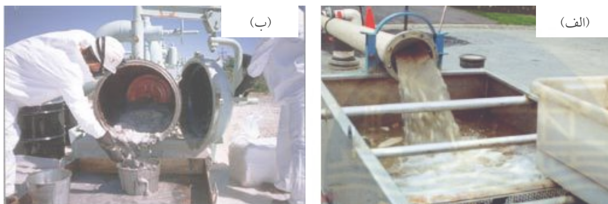
شکل (8) - روش‌های پاکسازی لوله‌های انتقال مواد نفتی: (الف) روش Flushing (ب) روش Pigging
