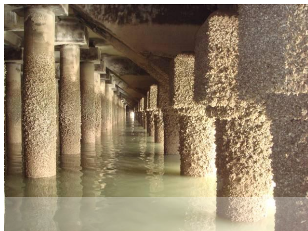
شکل 5- نمایی از شمع‌های ردیفهای دوم (L) و سوم (K) - جدار شمع‌ها در محدوده جزر و مد با موجودات دریایی (نام محلی گچسار) پوشیده شده
