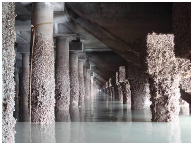
شکل 5- نمایی از شمع‌های ردیفهای دوم (L) و سوم (K) - جدار شمع‌ها در محدوده جزر و مد با موجودات دریایی (نام محلی گچسار) پوشیده شده
