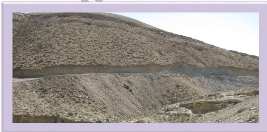
شکل ۴- حفر ترانشه بلدوزری
