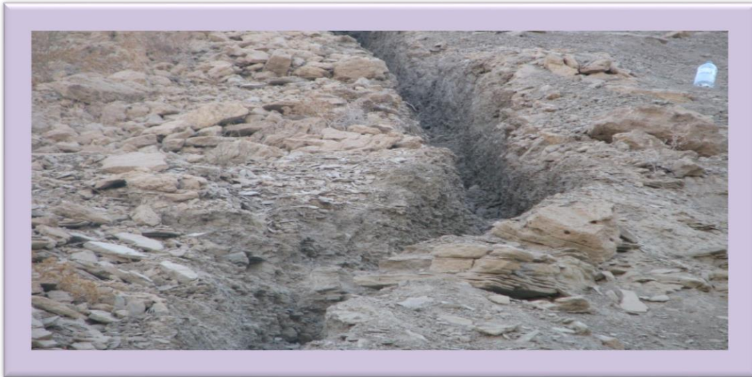
شکل ۵- حفر ترانشه دستی
