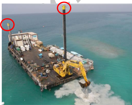
شکل ۱۰- اسپاد و محل نصب آن، ماخذ: Trench company
