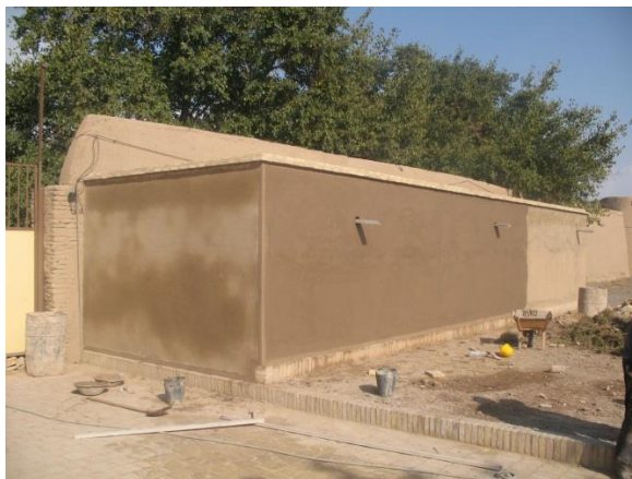
تصویر 4 نمای بیرونی آغل باغ رحیم آباد پس از مداخلات سال 1389
