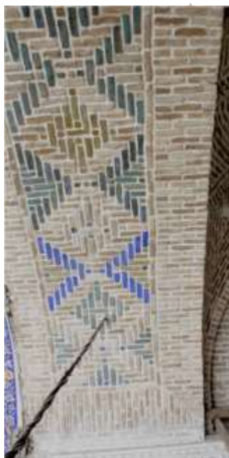
شکل ۱۴- عکس و موقعیت تویزه های تاق کاربندی
