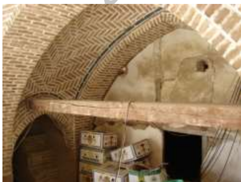
شکل ۱۶- تصویر تاق کجاوه و چفت از داخل فضای کمرپوش
