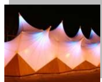
شکل ۵- فرمی که به وسیله کشیدن یک نقطه از غشا به مکانی خارج از صفحه به وجود می آید (۱)
