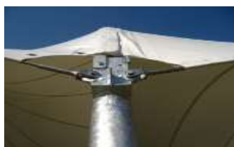
شکل ۱۱- اتصال کابل به دیرک و پارچه (۱)
