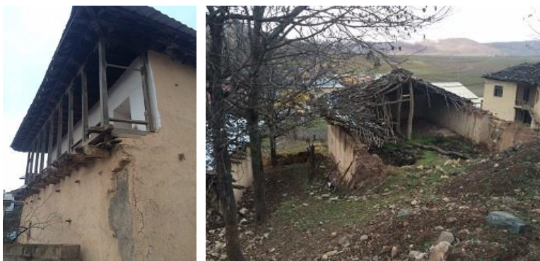
شکل 20- تیرهای سازه ای بیرون زده شده و تحمل وزن سقف به وسیله عصایی، روستای لاشک در بناهای روستای لاشک (منبع: نگارنده، پاییز 1394)
