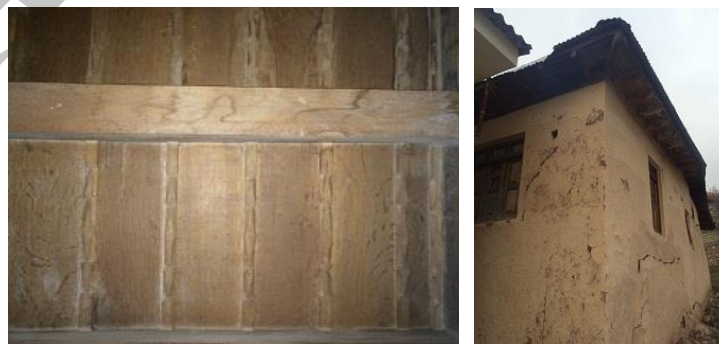
شکل 13- نحوه قرارگیری سقف شیروانی بر روی سقف صاف زیرین و پوشش سقف از داخل بنا در روستای لاشک (منبع: نگارنده، پاییز 1394)
