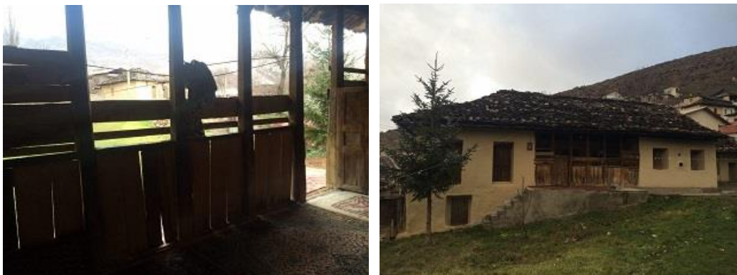
شکل 3- ساخت ایوان های روستای لاشک به عنوان پیش ورودی بنا و قرار دادن دیوار چوبی به منظور عملکرد مناسب در تابستان و زمستان (منبع: نگارنده، پاییز 1394)
