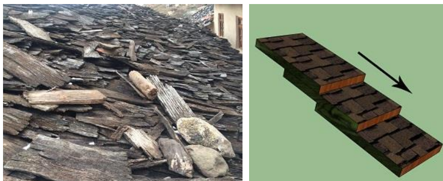
شکل 14- طریقه پوشش سقف با لته های چوب در خانه های روستای لاشک (منبع: نگارنده، پاییز 1394)
