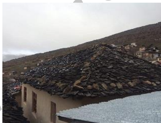
شکل 15- قرارگیری سنگ ها بر روی لبه های سقف (منبع: نگارنده، پاییز 1394)
