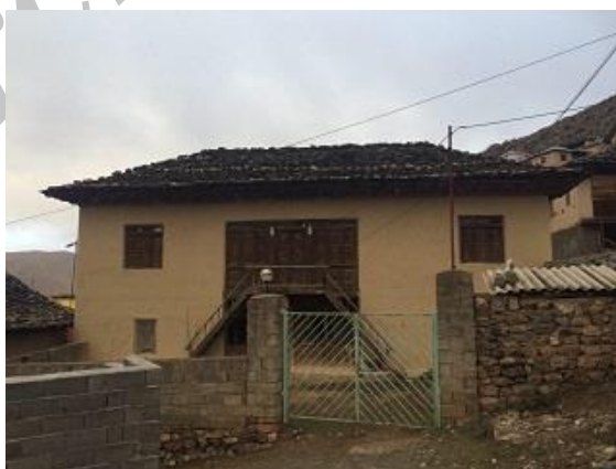
شکل 5- پله های آزاد قرار گرفته برای دسترسی به طبقه اول در خانه های روستای لاشک (منبع: نگارنده، پاییز 1394)
