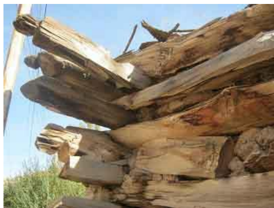
شکل 9- طریقه قرار گیری چوب ها در ساخت در بناهای روستای لاشک (منبع: نگارنده، پاییز 1394)
