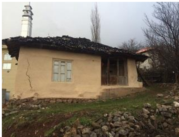
شکل 6- ساخت بنای کاهگلی بر روی بستری از سنگ و گل، روستای لاشک (منبع: نگارنده، پاییز 1394)
