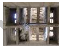
عکس ۲: تیغه‌های اجرا شده بر روی چوب‌های عمود برهم
