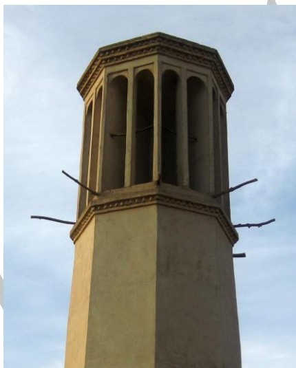
تصویر شماره 4 بادگیر هشت طرفه با مقطع هشت وجهی در یزد
