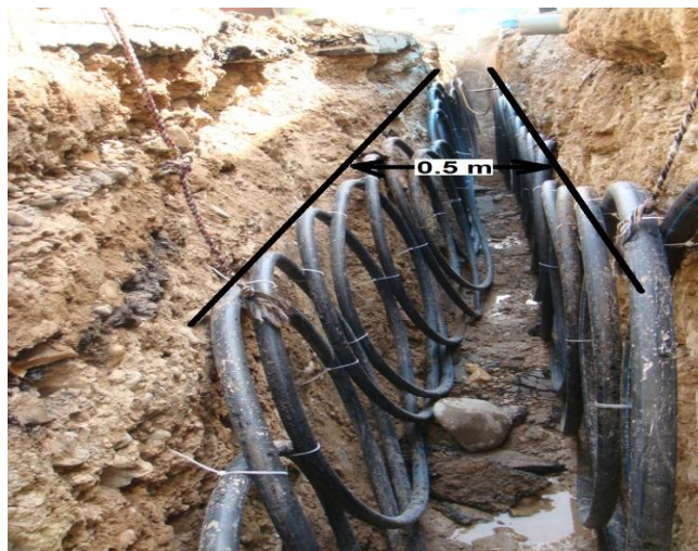
شکل 4- نحوه استقرار کویل زمینی در خاک
