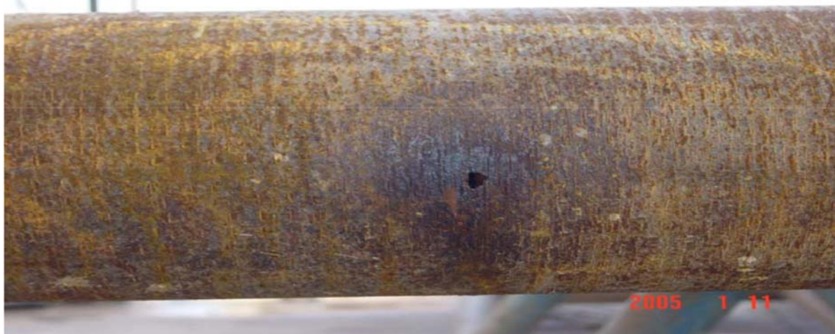
(۱) شکل فوق خوردگی شیاری لوله های حفاری را نشان می دهد.
