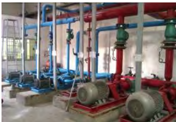
شکل ۱۱: مرکز پمپاژ (الکتروپمپ های آب شرب و آتش نشانی)
