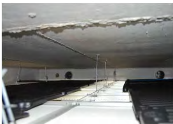
شکل ۳- نمونه اجرا شده سقف تهویه شده [4]
