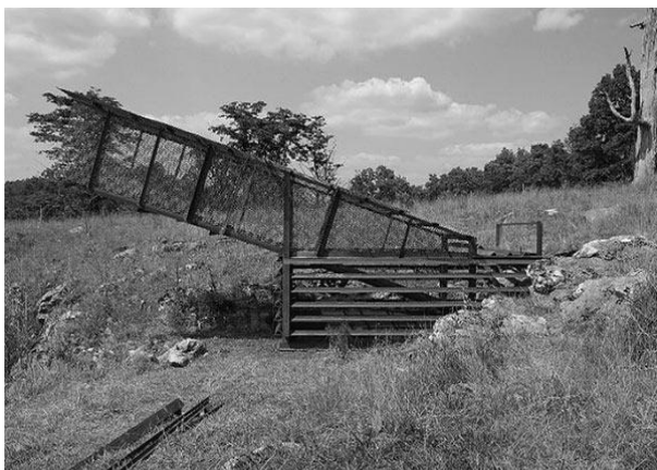
درب ناودانی (Chute Gate)
