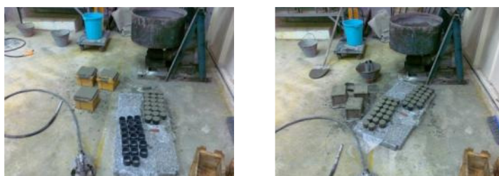
شکل ۲- ساخت اسپسیرهای بتنی
