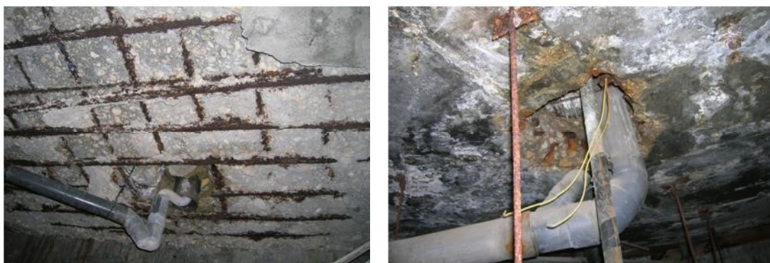
شکل ۴- ارزیابی چشمی دال سقف
