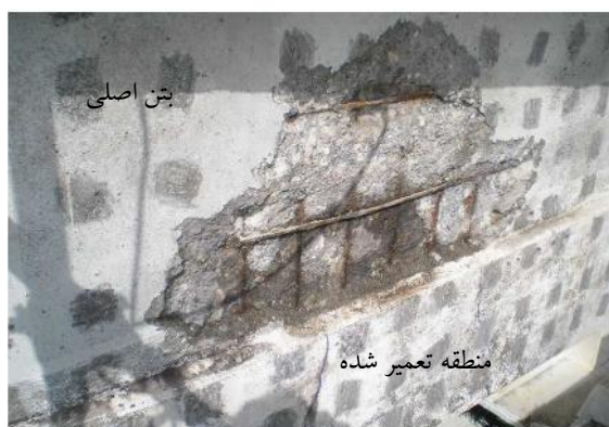
شکل ۱۶- تشکیل آند تکوینی در مجاورت مناطق ترمیم شده
