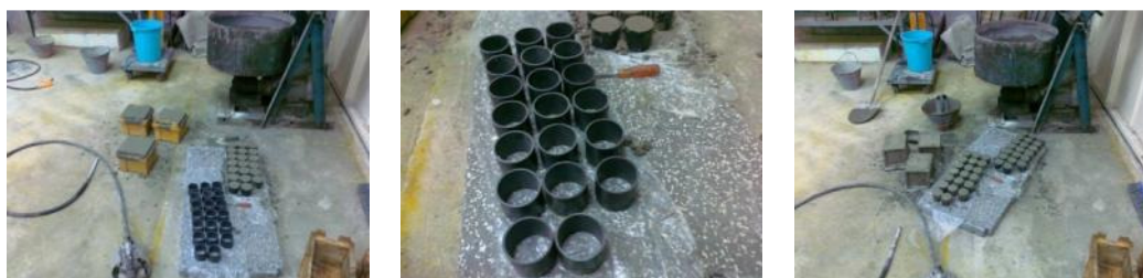
شکل ۱- ساخت اسپیسرهای بتنی
