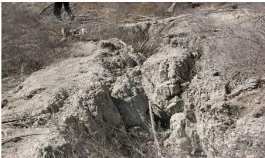
شکل ۷: شکاف‌های ایجاد شده طولی در طرفین نشست که دارای عمقی بیش از ۱/۵ متر هستند
