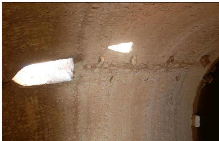
شکل ۱۳: نمایی از پاکنه های یک آب انبار
