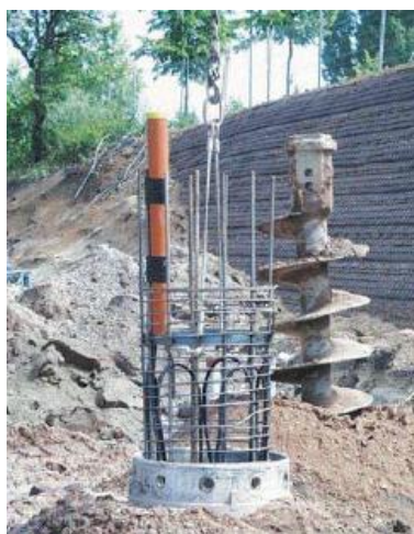
شکل ۱- نمونه ای اجرا شده از شمعهای ژئوترمال
