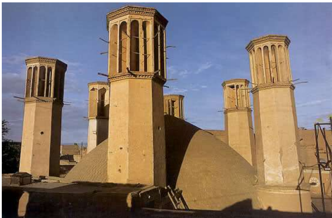
شکل ۱۰- آب انبار شش بادگیر (قاجاریه) - یزد
