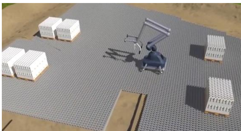
شکل ۳. اجرای پی ساختمان با آجرهای هوشمند ( http://kitebricks.com )
