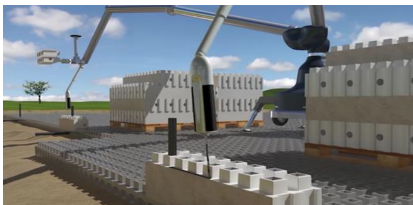
شکل ۵. اجرای دیوار ساختمان با آجر های هوشمند ( http://kitebricks.com )
