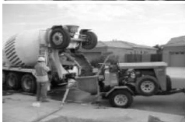
شکل (۴) تهیه و تخلیه مواد در میکسر و پمپ در روش مخلوط تر
