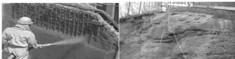
شکل (۱) بتن پاشی روی سطح عمودی دیوار
