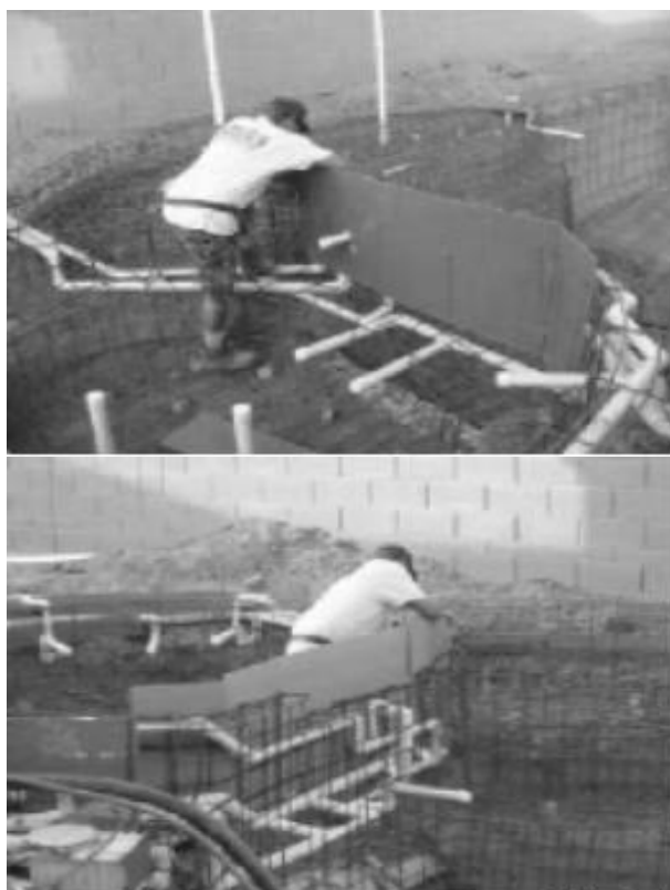
شکل (۵) و (۶) استفاده از سپر چوبی برای استقرار بتن شاتکریت
