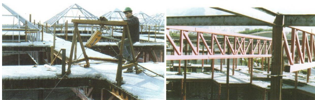
تصویر ۲۶: مراحل اجرایی سقف و نورگیرها مجموعه تیراژه
