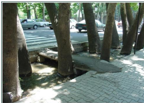
شکل ۳- عرض کم پل عابر شکل ۴- شیب نامناسب اتصال پل به پیاده‌رو
