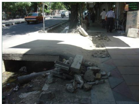
شکل ۳- عرض کم پل عابر شکل ۴- شیب نامناسب اتصال پل به پیاده‌رو
