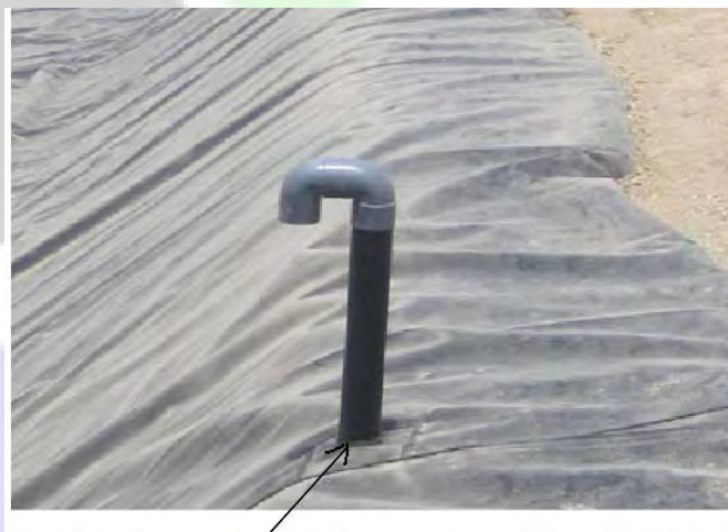
شکل ۵: چگونگی اجرا لوله های vent
