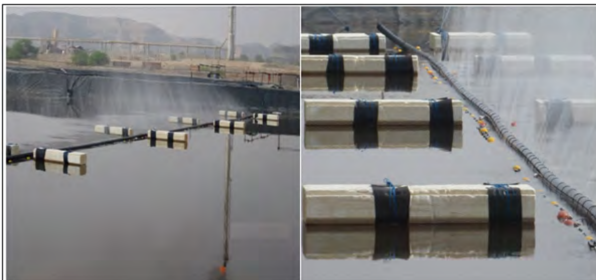
شکل ۷: تجهیزات اسپری کردن آب به هوا در حوضچه تبخیر
