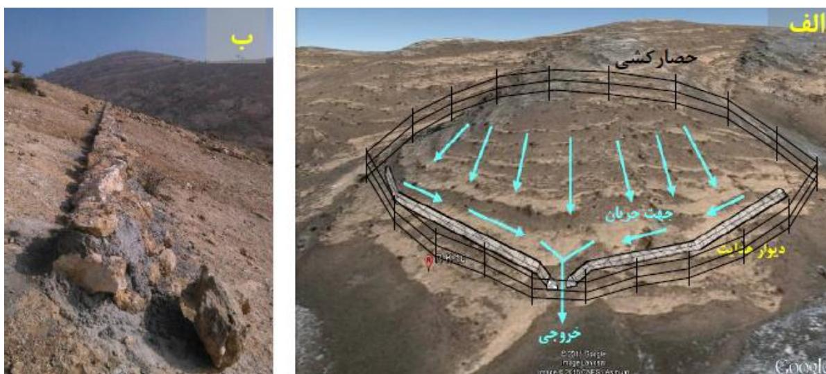
شکل ۴ - دیوار هدایت رواناب به همراه مقطع عرضی، حصارکشی سطح آبگیر و جهت جریان (الف)، دیوار هدایت در حال ساخت (ب)
