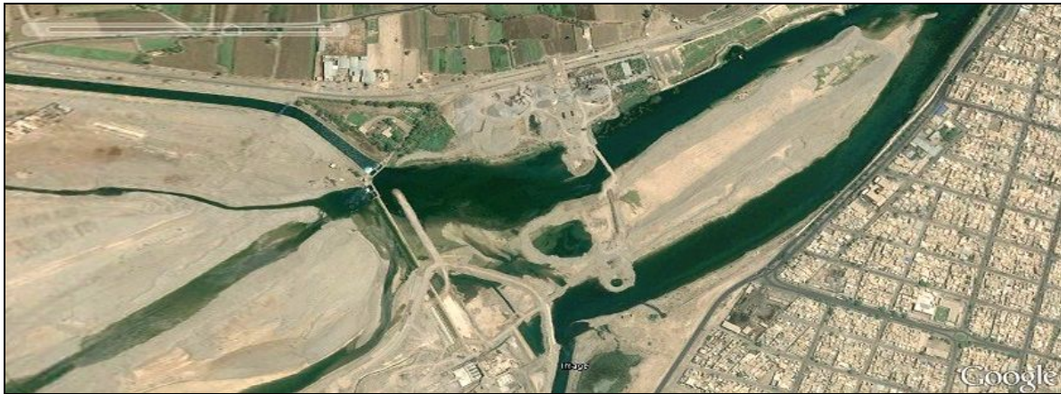
شکل (۵) بند انحرافی دز و تقسیم آب به کانال های آبیاری شرق و غرب
