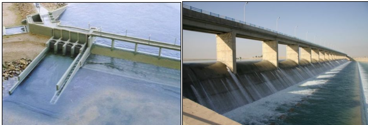
شکل (۷) سر ریز شدن آب روی سرریز بند انحرافی دز
