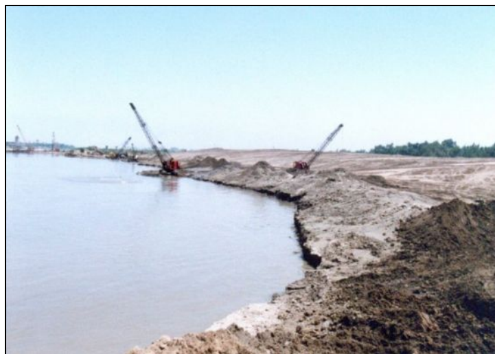
شکل (۸) رسوبات بالادست بند انحرافی
