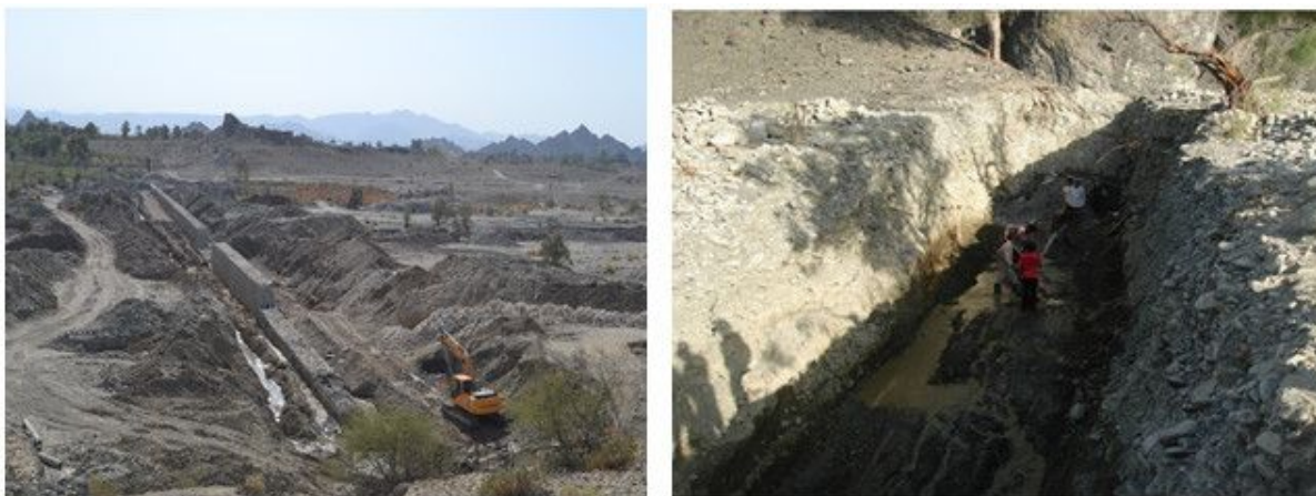
شکل ۳- حفر ترانشه ها برای احداث سد زیرزمینی
