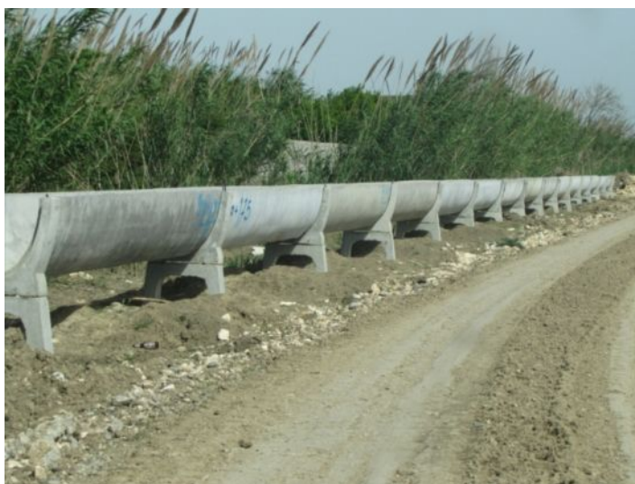
شکل (۲): کانالت نصب شده در محور P2-S1-TC6-روستای افراتخت
