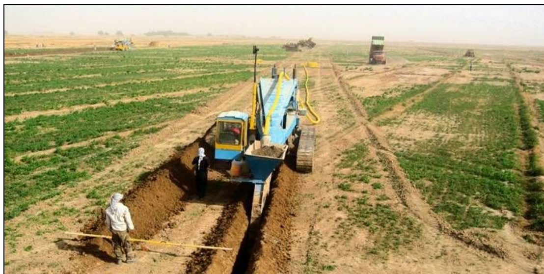
شکل (۱۰) اراضی دشت آزادگان و عملیات نصب لوله زهکش های زیرزمینی
