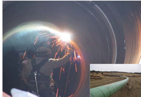
شکل ۱ جوش کاری داخل یک لوله نازک [۹،۸]
