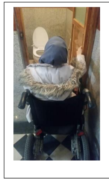
تصویر شماره ۲۰، در صورت وجود سرویس بهداشتی عمومی، عدم امکان ورود ویلچر به داخل آن.
