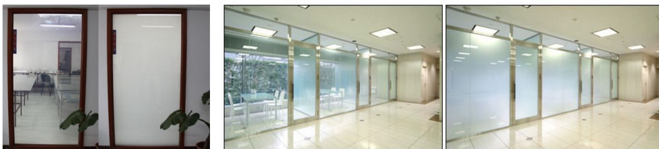
شکل ۱۳ و ۱۴: در و پنجره‌های هوشمند الکتروکرومیک در فضای داخلی معماری [۷]
