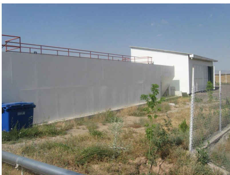
شکل ۸- پکیج تصفیه خانه موجود بعد از بازسازی - خوابگاههای برداران
