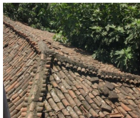
تصویر ۱۱: پوشش سقف بنای قاجار
