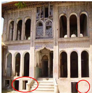
تصویر ۶: زیرزمین یا گربه رو در خانه قاجار (مأخذ: سازمان میراث فرهنگی، ۱۳۹۴)
