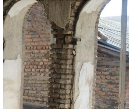
مصالح آجر در بنای آجری خانه قاجار
