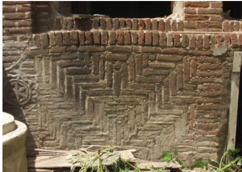
ملات گچ و خاک و نوع آجرچینی در بنای قاجار
