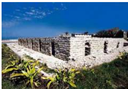
شکل 10 - آب انبار قوام بوشهر
