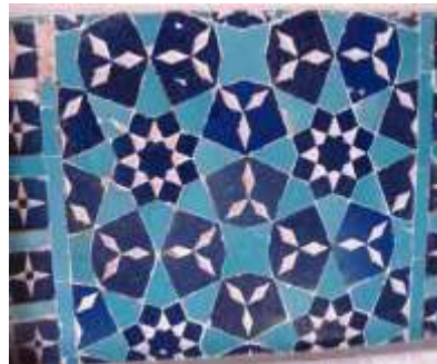
شکل 8- کاشی معرق و لعاب پران، نوار تزئینی ایوان جنوبی گنبد سلطانیه (شکری، 1394)
