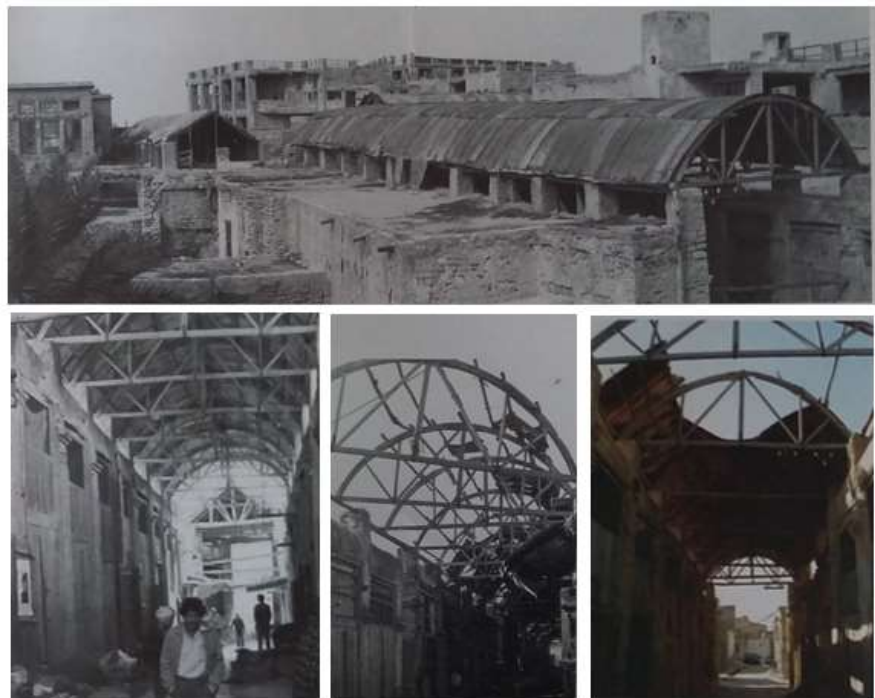
(تصویر شماره 17 : نمونه پوشش سقف مدور در بازار بوشهر (ترسیم : نگارنده ، ماخذ تصاویر : بازار ایرانی ، جهاد دانشگاهی: 187))
