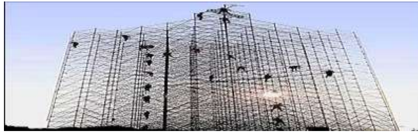
شکل ۱- کار در ارتفاع برای ساختمان سازی
