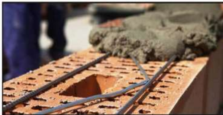
شکل 6- میلگرد بستر خرپایی قبل از پخش کردن ملات بستر بر روی آن
