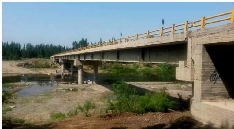
شکل 3: نمایی کلی از پل نظام آباد میاندوآب
