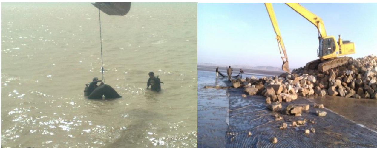
شکل ۵: نحوه قرار دادن ژئوتکستایل بر روی خاک سست و قرار دادن ذرات بر روی ژئوتکستایل
