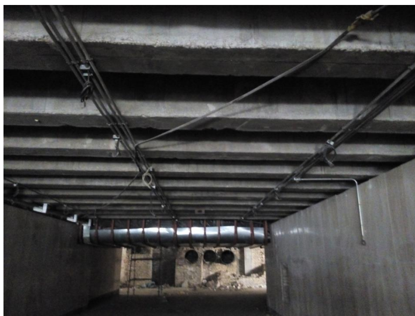
شکل ۱۰: نمایش سیستم تیرریزی زیر سطح خیابان
