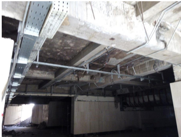
شکل ۱۱: نمایش سیستم تیرریزی ورودی خیابان توحید
