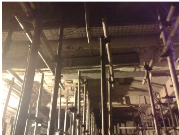
شکل ۱۷: داربست بندی زیر عرصه میدان به جهت تقویت سازه آن
