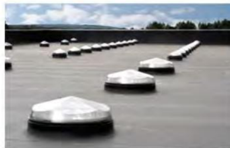
شکل ۹: استفاده از لوله خورشیدی در سقف (Heidemann, 2001)
